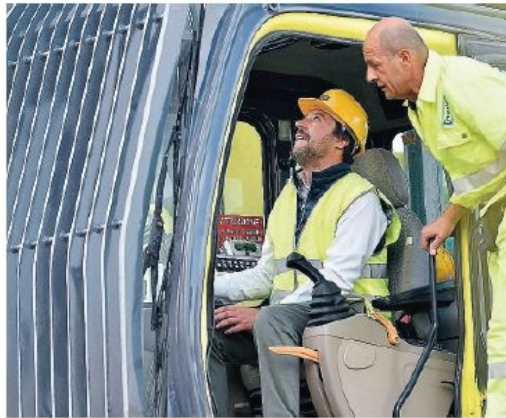
Con l'elmetto. Matteo Salvini a Zingonia per la demolizione di due edifici degradati
